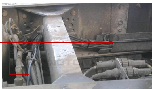
Рисунок 22 — Укладка сигнального кабеля DFM
